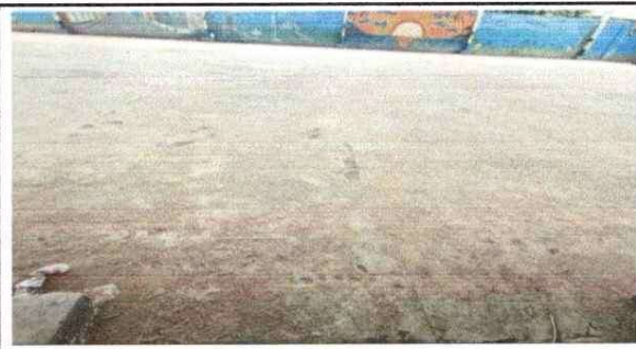
Foto2: Sustrucción de piso de torta de concreto
