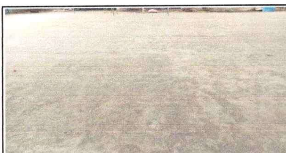
Foto 5: Sustrucción de piso de torta de concreto
