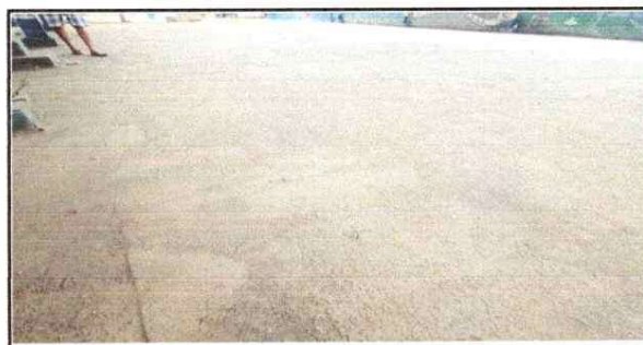
Foto 6: Sustrucción de piso de torta de concreto
