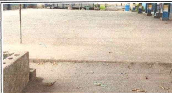
Foto1: Sustrucción de piso de torta de concreto
