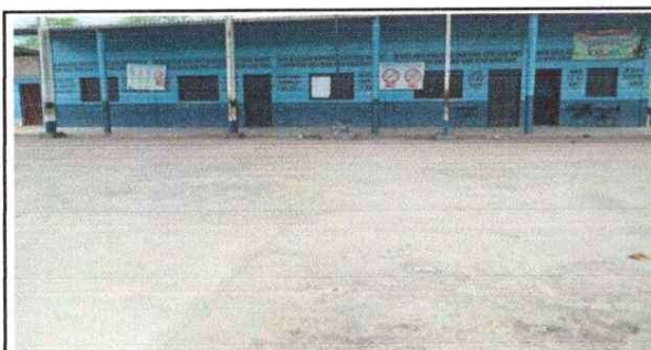
Foto 3: Sustrucción de piso de torta de concreto
