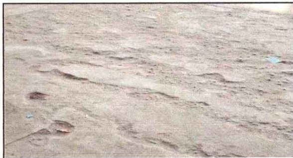
Foto 4: Sustrucción de piso de torta de concreto
